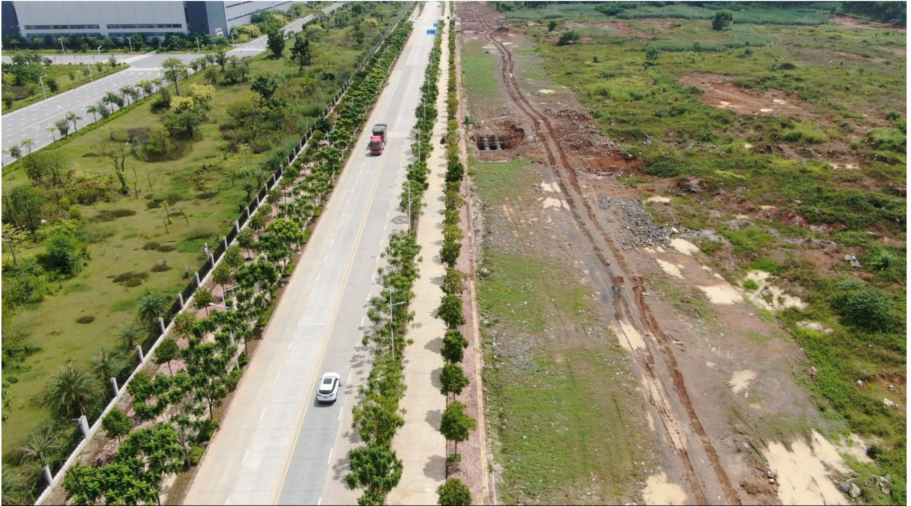
图 7 管网工程区已埋设段恢复绿化现状
