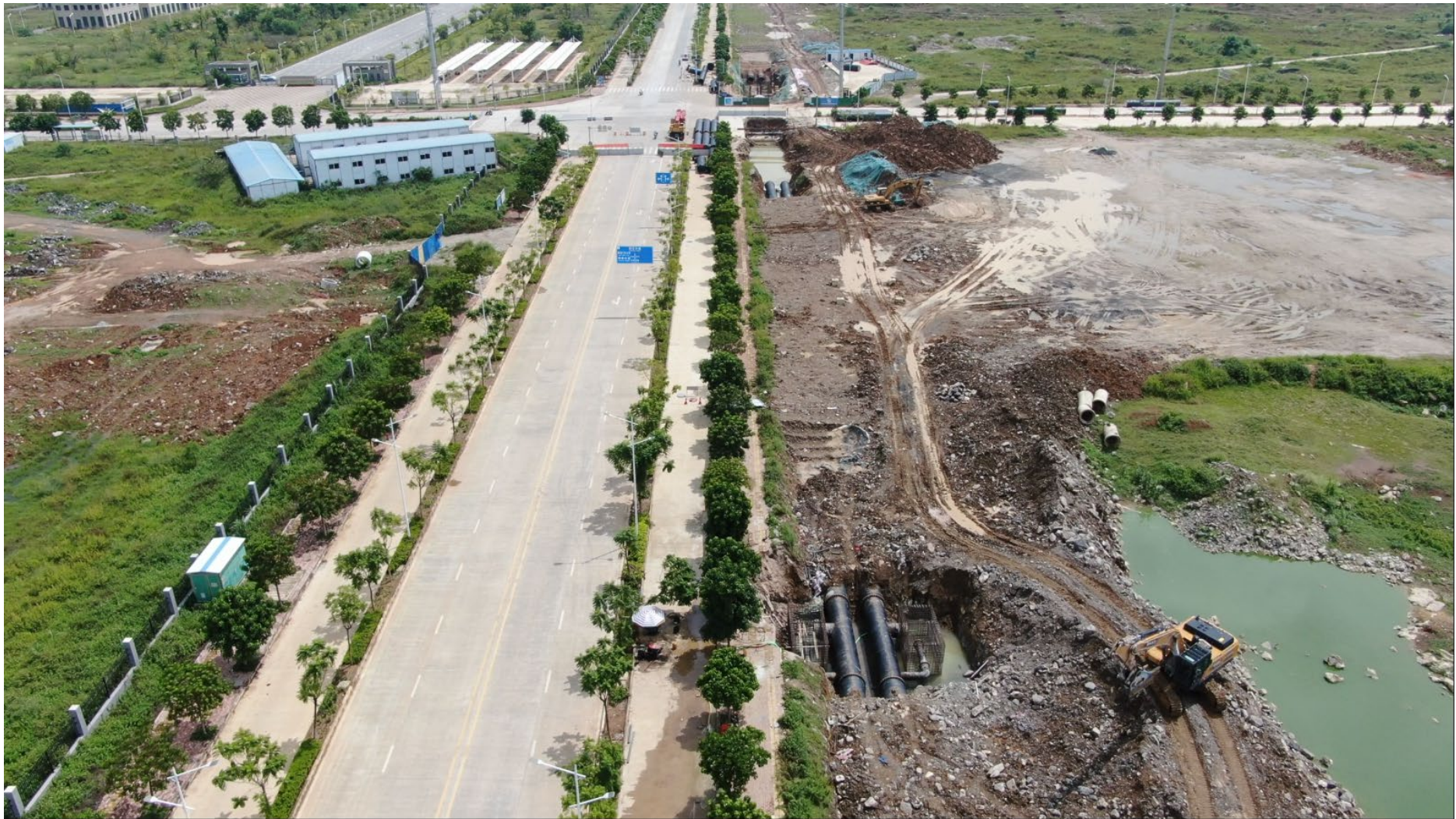
图 4 管网工程区已回填和已开挖区域现状 2
