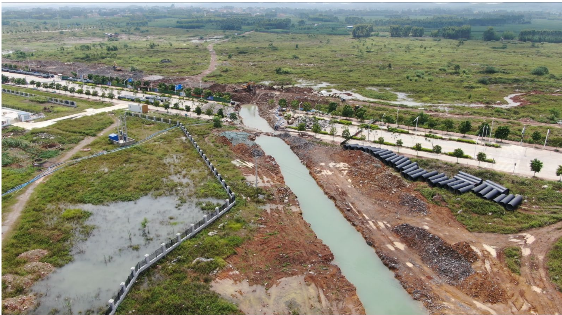
图 2 管网工程区穿越进港五路段施工现状
