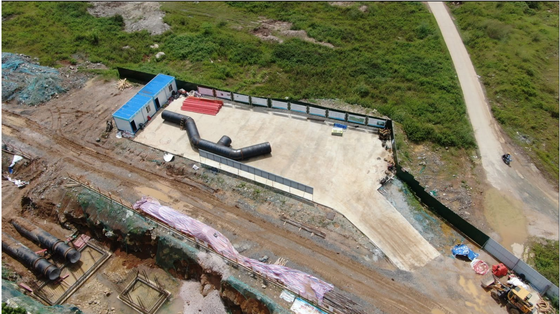
图 6 施工生产区现状
