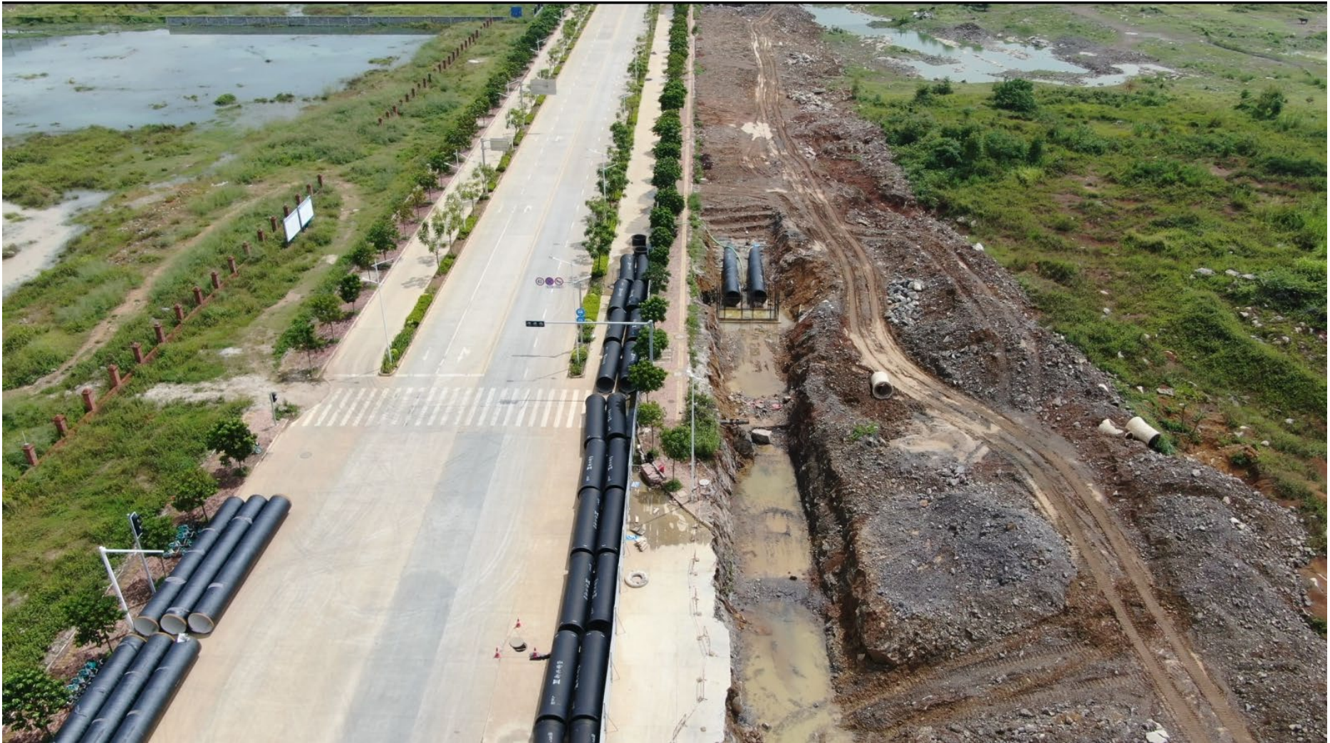
图3 管网工程区已回填和已开挖区域现状 1
