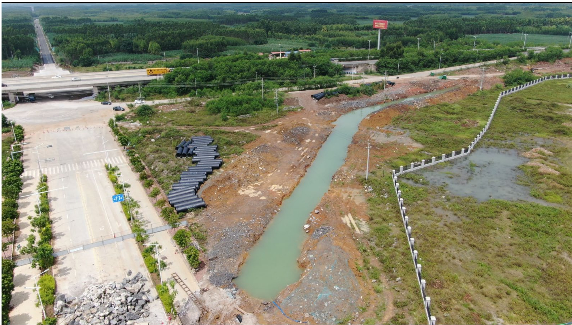
图 1 管网工程区施工现状图
