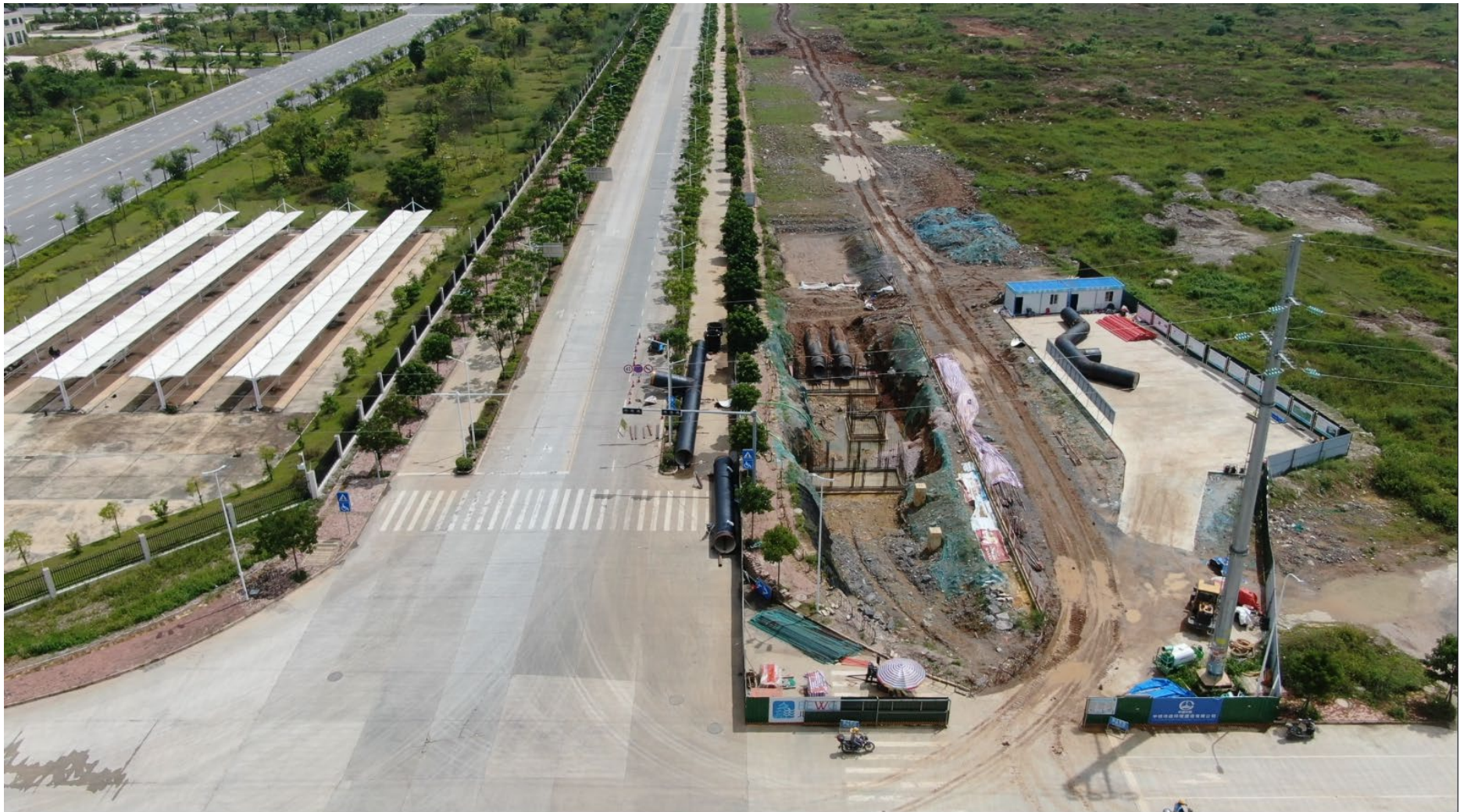
图 5 管网工程区施工段沿线边坡铺设密目网覆盖现状
