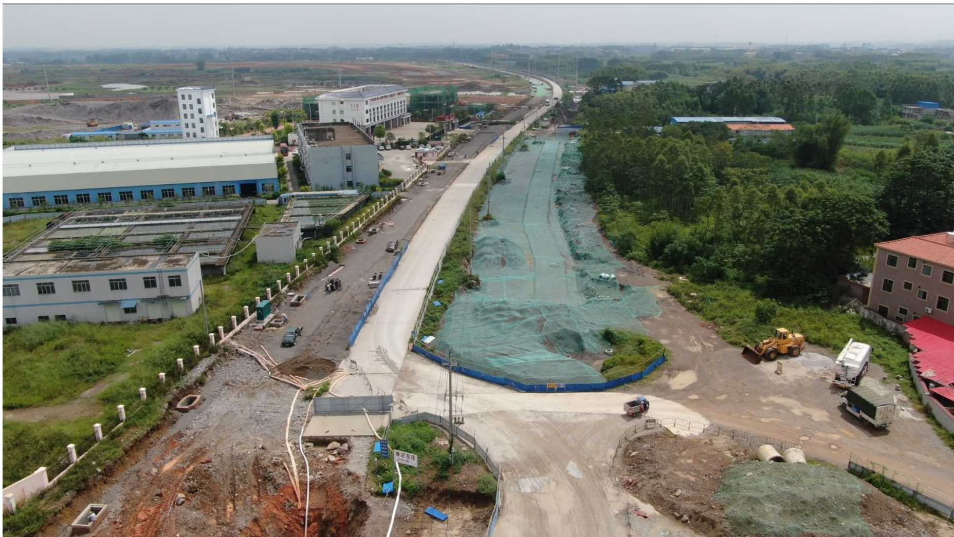
图 8 管网工程区已回填区域铺设密目网现状
