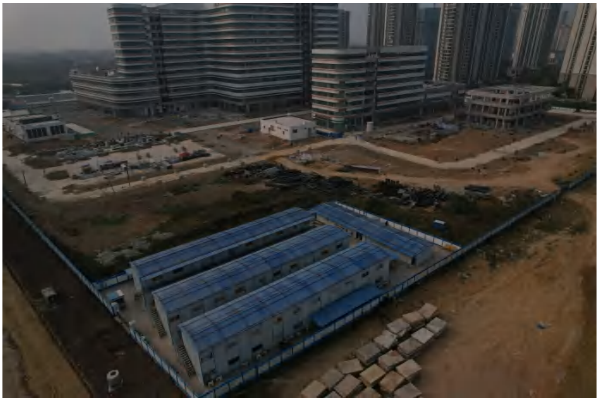
施工生产生活区现状(2023年4月3日拍摄)
