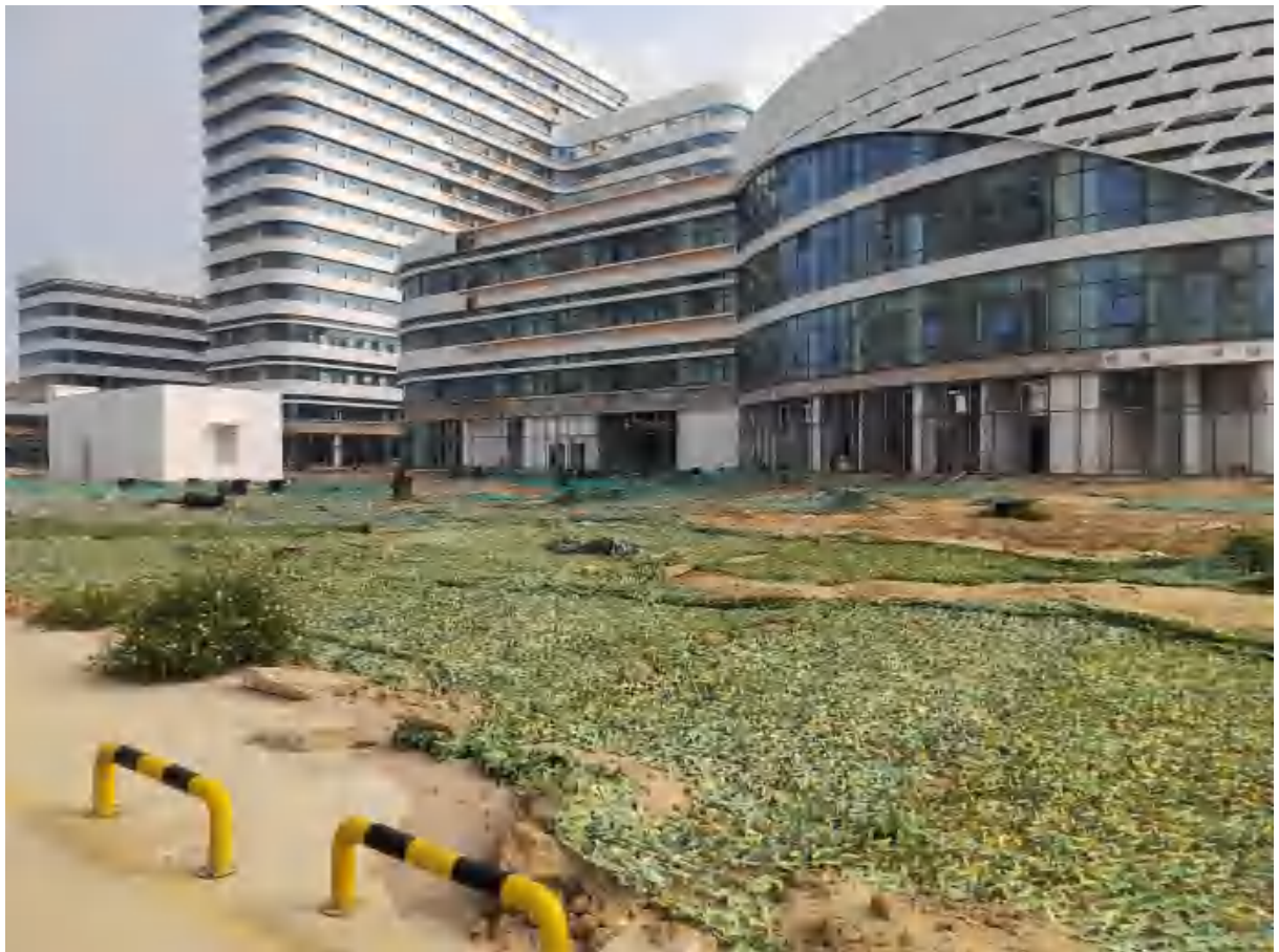
项目内部实施临时苫盖区域现状(2023年4月3日拍摄)
