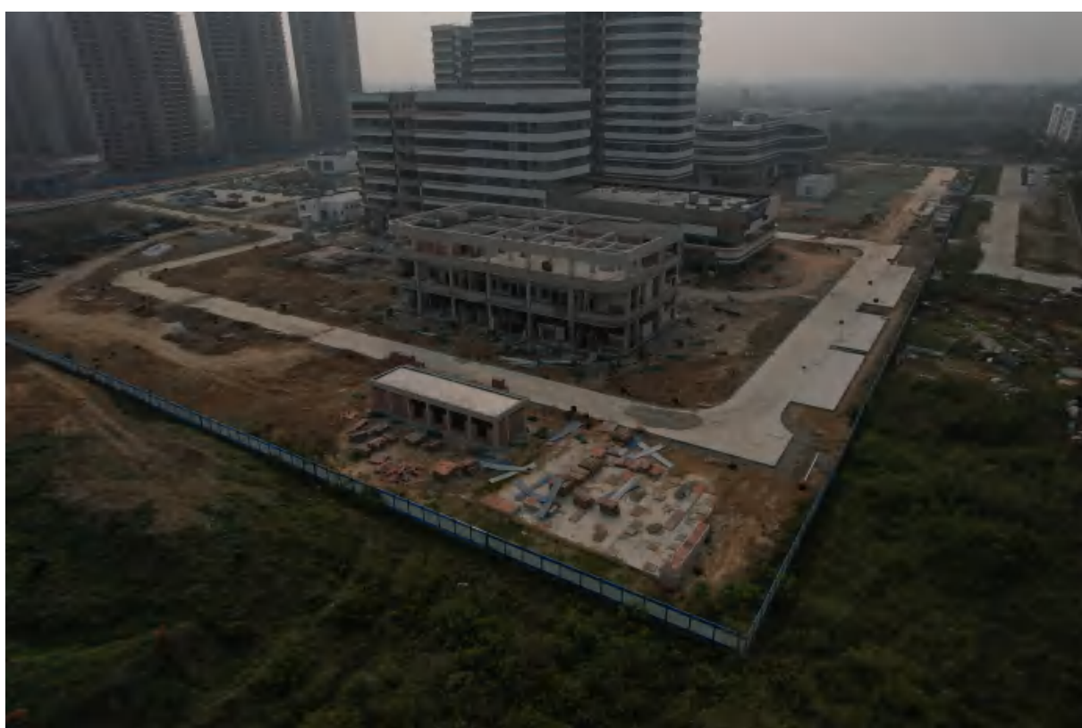
项目西北部现状 (2023 年 4 月 3 日拍摄)
