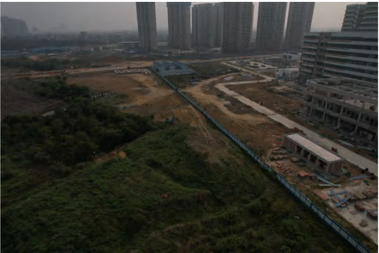
项目区临时堆土区现状(2023年4月3日拍摄)
