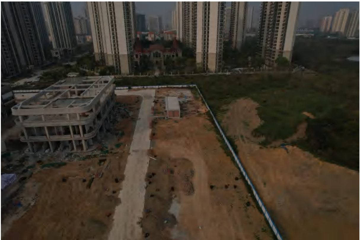
项目区临时堆土区现状(2023年1月3日拍摄)
