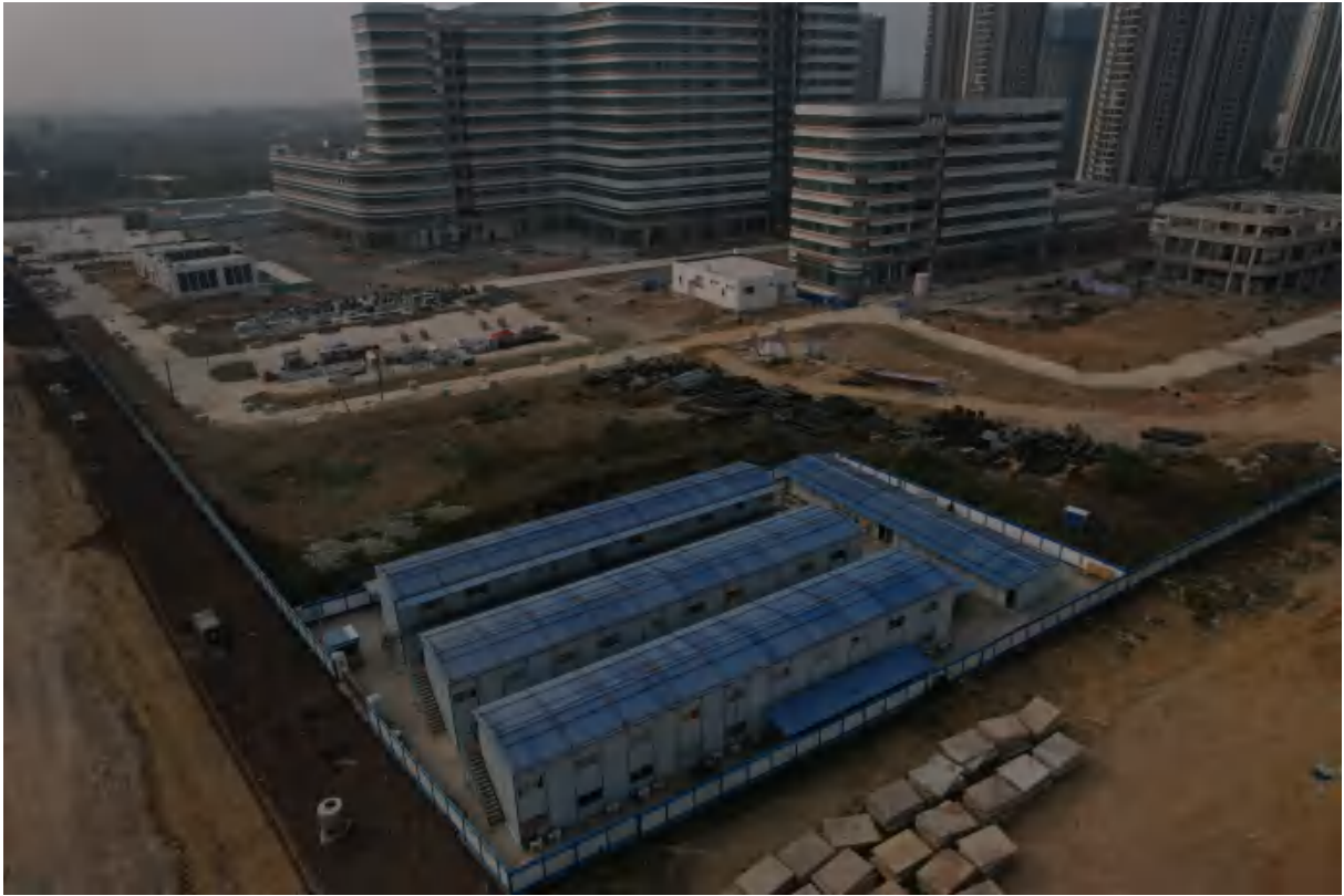
项目东北部现状 (2023 年 1 月 3 日拍摄)
