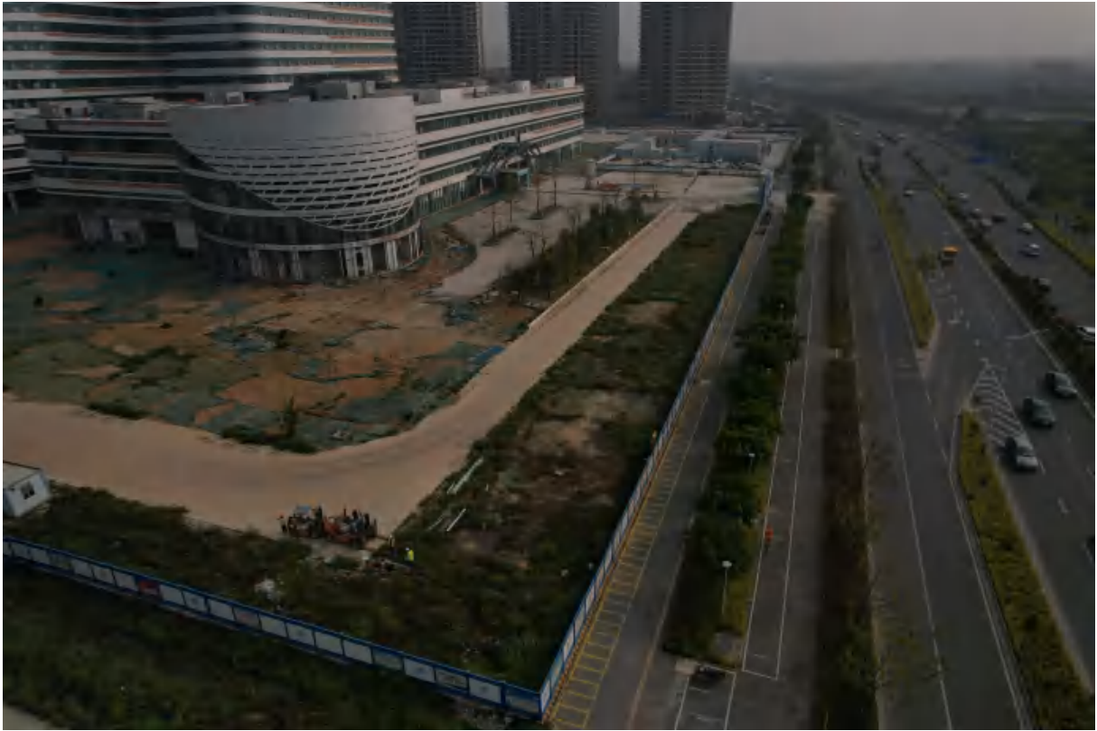
项目西南部现状 (2023 年 1 月 3 日拍摄)
