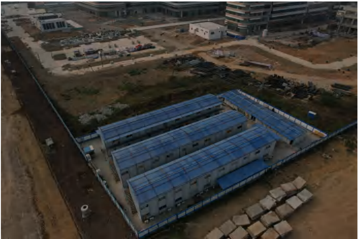
施工生产生活区现状(2023年1月3日拍摄)
