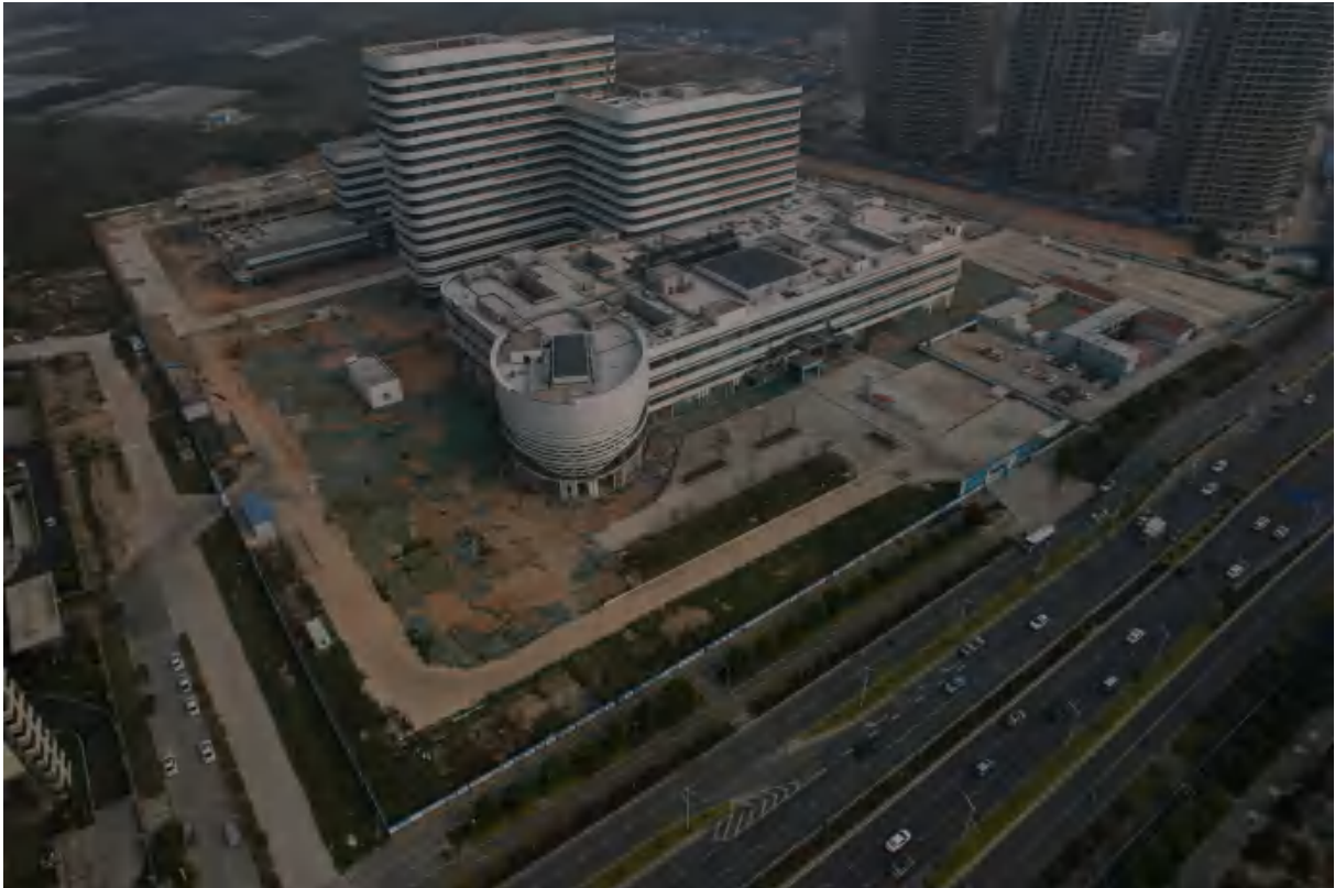
项目现状全景图 (2023 年 1 月 3 日拍摄)
