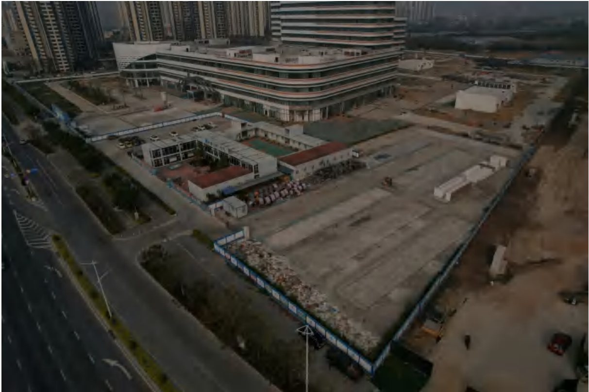
项目东南部现状 (2023 年 1 月 3 日拍摄)
