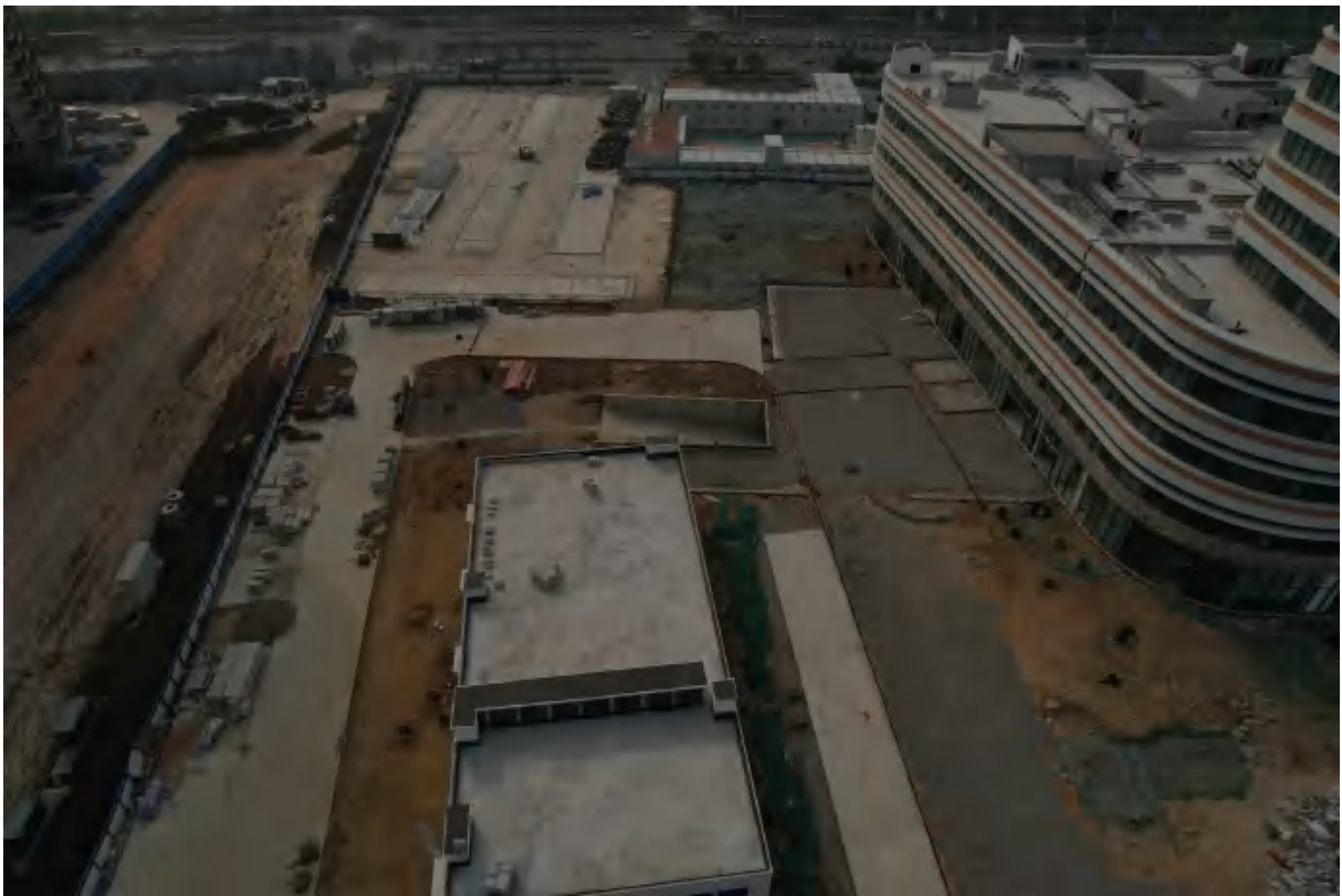
项目内部实施临时苫盖区域现状(2023年1月3日拍摄)
