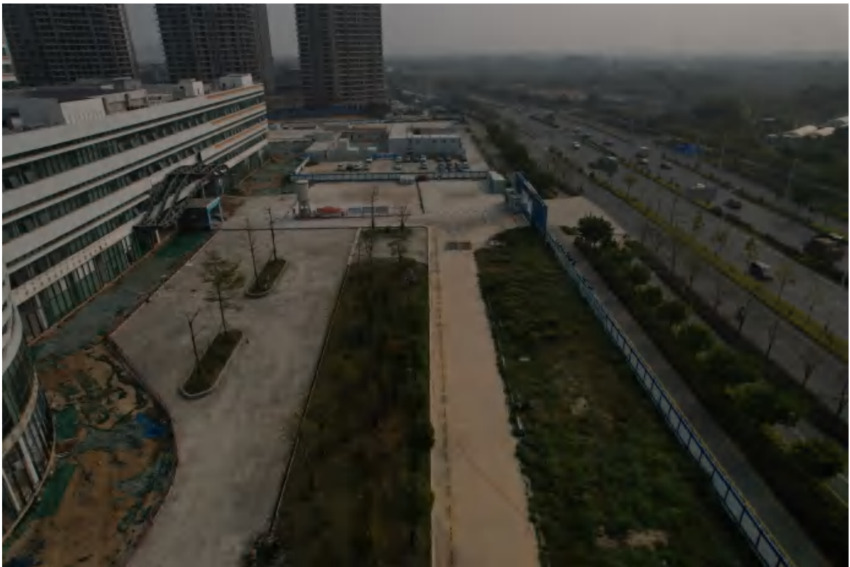
项目已布设洗车池现状 (2023 年 1 月 3 日拍摄)
