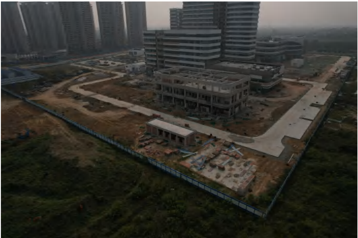
项目西北部现状 (2023 年 1 月 3 日拍摄)
